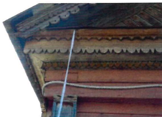
Фрагмент северо-восточного фасада, карниз 1-го этажа
