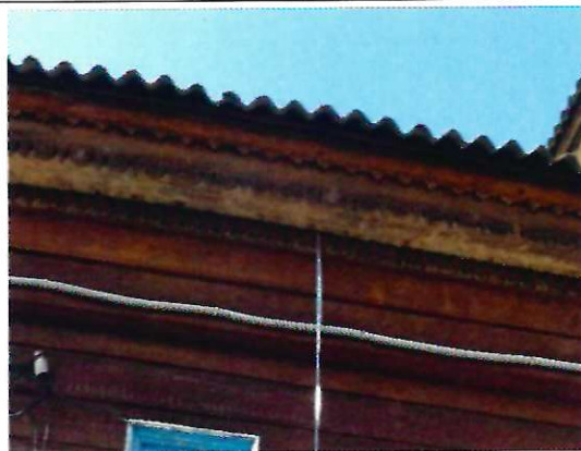
Фрагмент северо-западного фасада, карниз 1-го этажа
