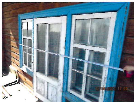
Фрагмент юго-восточного фасада
