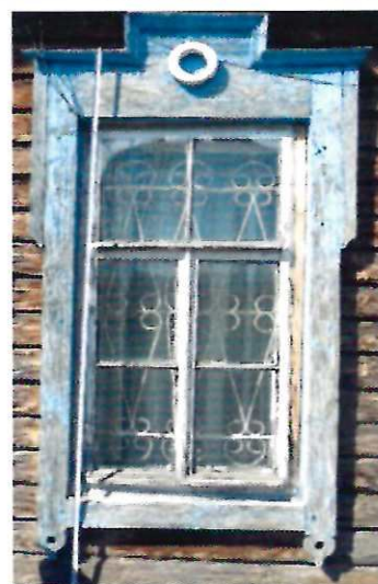
а) Фрагмент юго-восточного фасада
