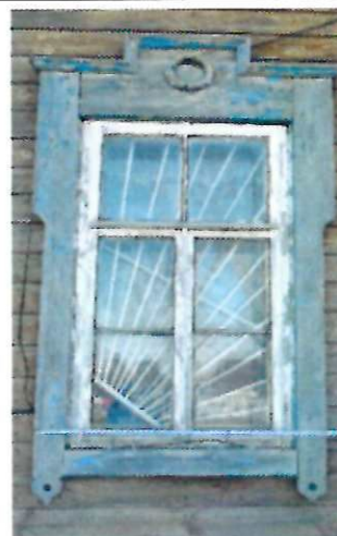
б) Фрагмент северо-западного фасада
