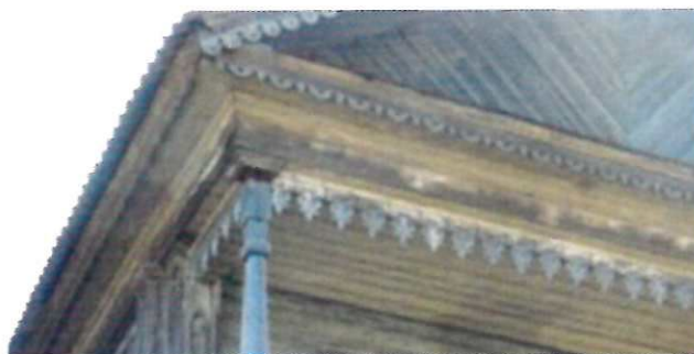
Фрагмент северо-западного фасада, карниз мезонина
