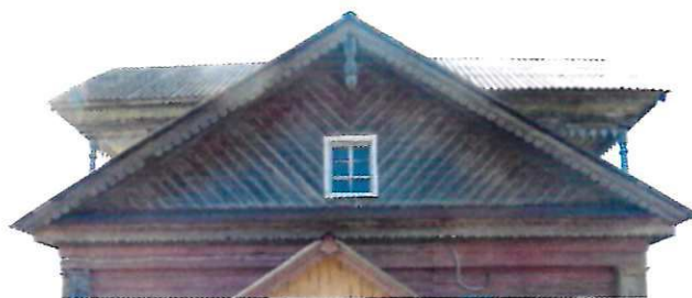
Фрагмент северо-восточного фасада
