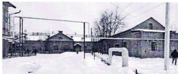
Дворовый (восточный) фасад
