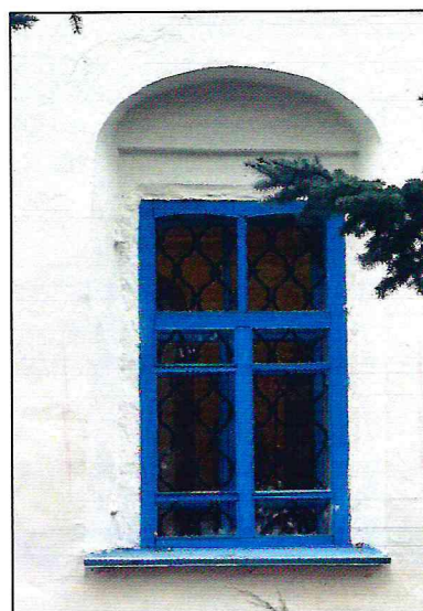
Отделка фасадной поверхности
