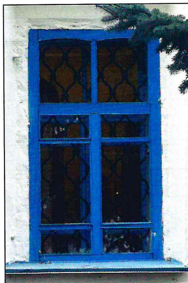
Заполнение оконного проема
