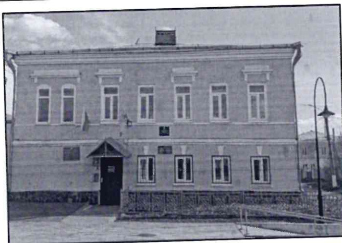
Северный фасад с улицы Набережная
