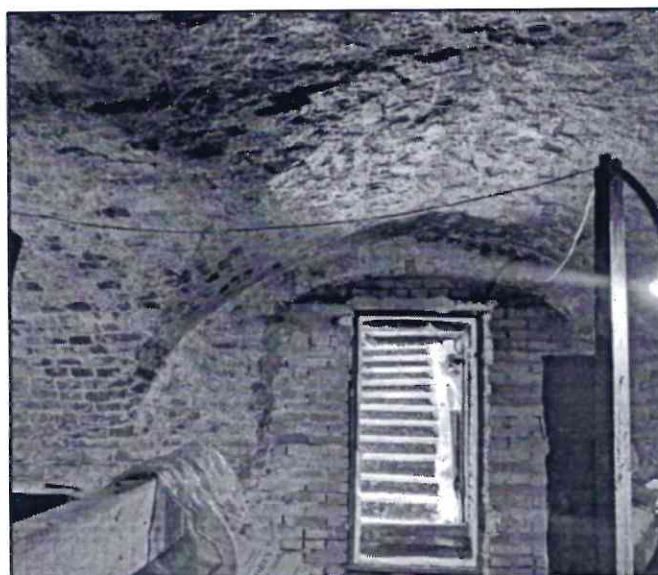
Распалубка над дверным проемом
