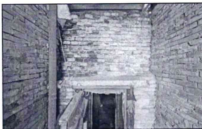
Кирпичные стены помещения лестницы
