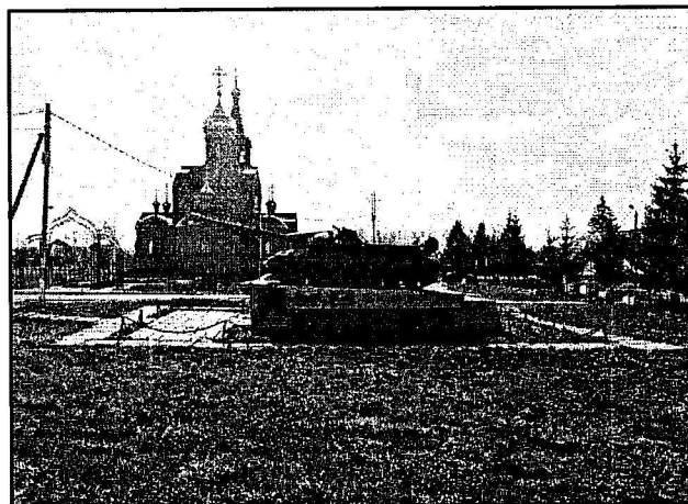
Северо-восточная сторона объекта с пешеходной части проспекта Ленина
